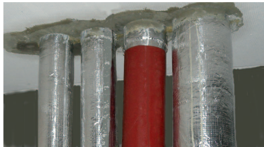
Bild 6 • Gussrohr DN 100 mit UBA-UNI Abschottung für Metallverbundrohr und Edelstahlrohr nach dem Deckenverguss. Zu beachten ist: Wird die Ver Schalung und der Deckenverguss von anderen Gewerken ausgeführt, muss der Installateur dennoch die Verantwortung dafür übernehmen. Durch einen Abstand von 20 mm in der Decke wird dies erleichtert und die Zwickel (zwischen den Rohren) sind in der Ausführung sicherer und kontrollierbar.
